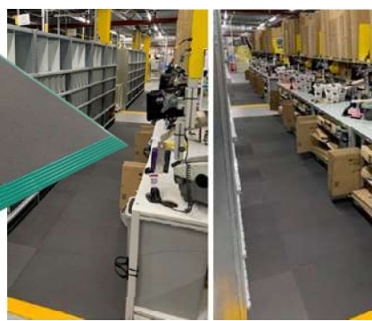
Bæredygtige måtter installeret hos en kunde.
