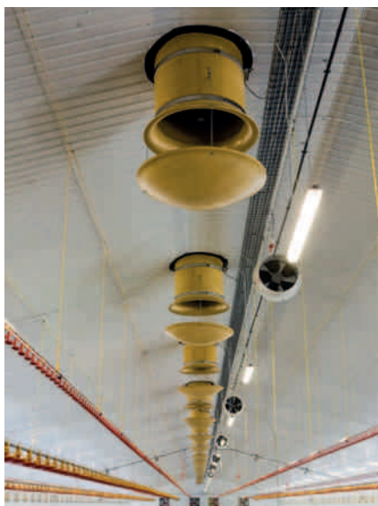
TPI Polytechnik BV – ventilation i en svinestald
